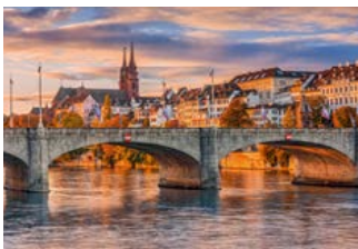
Mittlere Brücke, Münster, Basel
